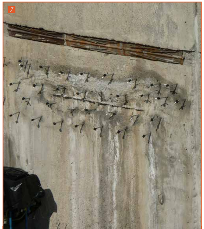
4) Injektáž stropov a stien pod uhlom 90°
